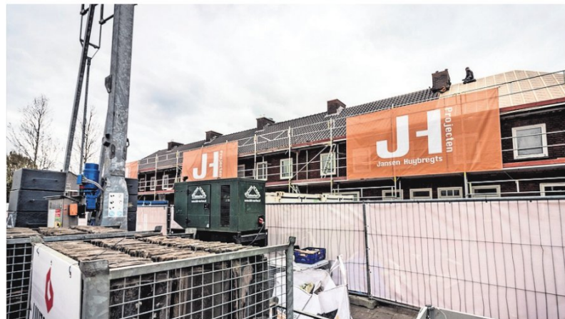
▲ Oude dakpannen van woningen aan de Burgemeester van Houtlaan gaan in kratten van Luijtgarden (voorground). Dat bedrijf gaat ze recycleren. FOTO SEM WIJNHOFEN/FOTOMEULENHOF
